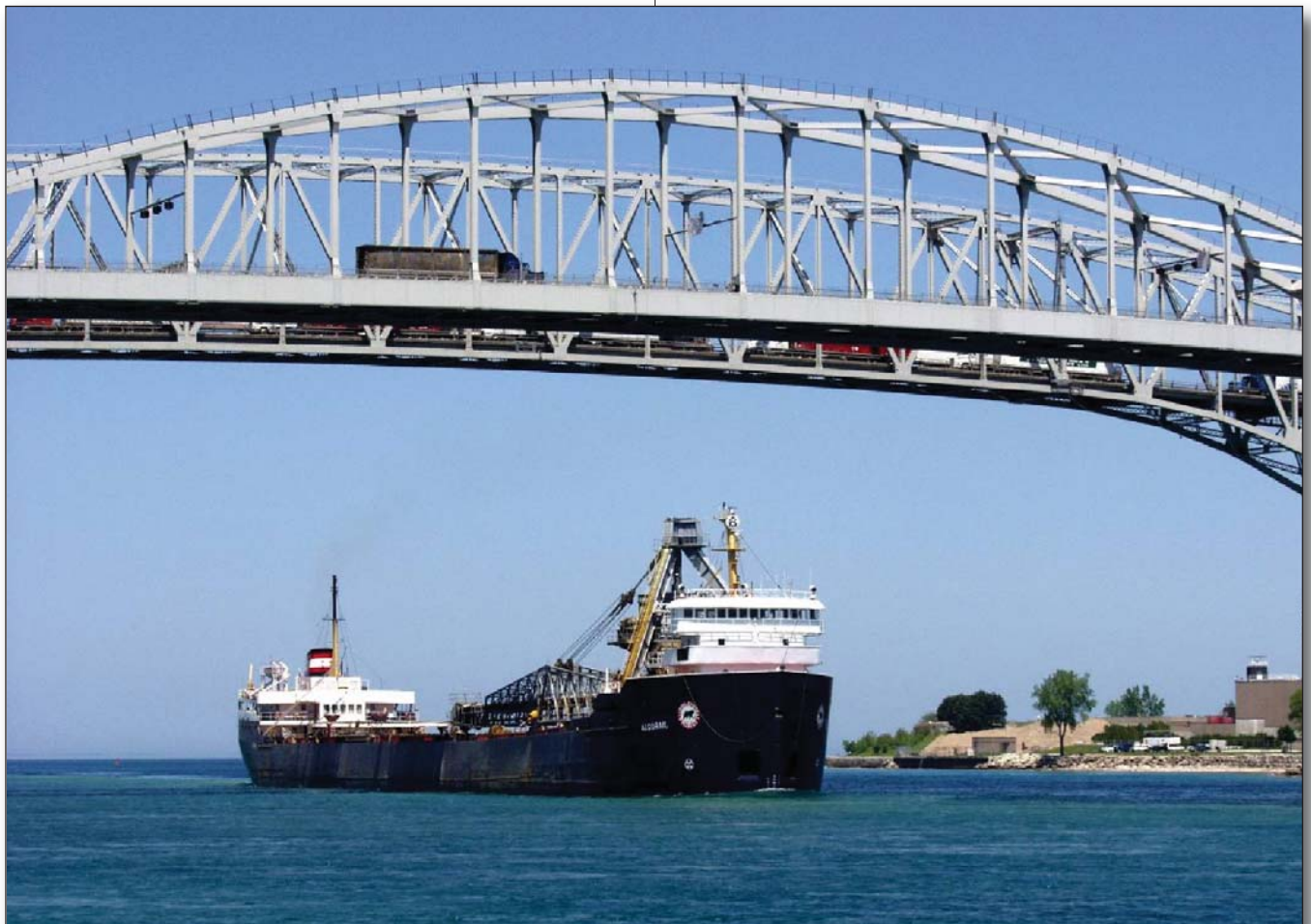
Un navire de charge entre dans la rivière Sainte-Claire, passant sous le pont international Blue Water. Le premier rapport de l'Étude porte sur les processus physiques et les possibles changements en cours dans la rivière et leurs effets sur les niveaux d'eau des lacs.
