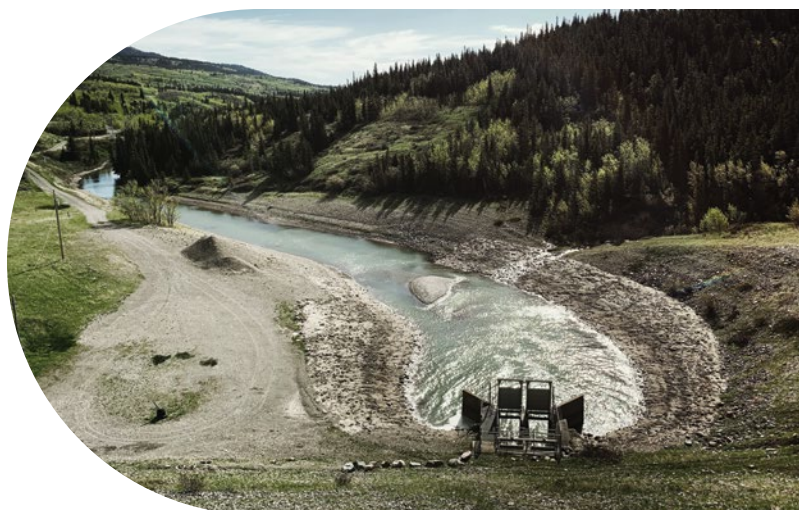
Figure 13 : Vue du lac Sherburne et de son déversoir dans le parc national des Glaciers, Montana. Source : Ethan Johnston.
