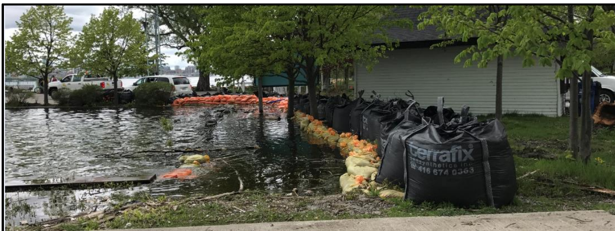
Figure 5-28 : Érection de murs de sable sur l'île de Toronto, le 26 mai 2017. Photo : © Toronto and Region Conservation (TRCA)
